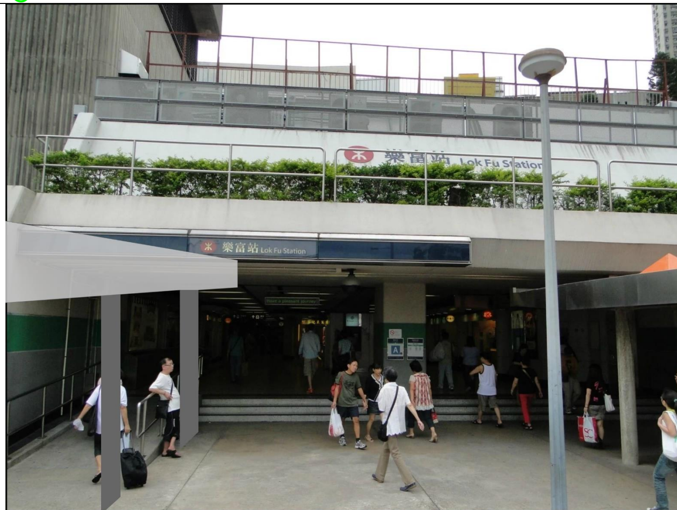
A 出口的斜道需要增設上蓋
