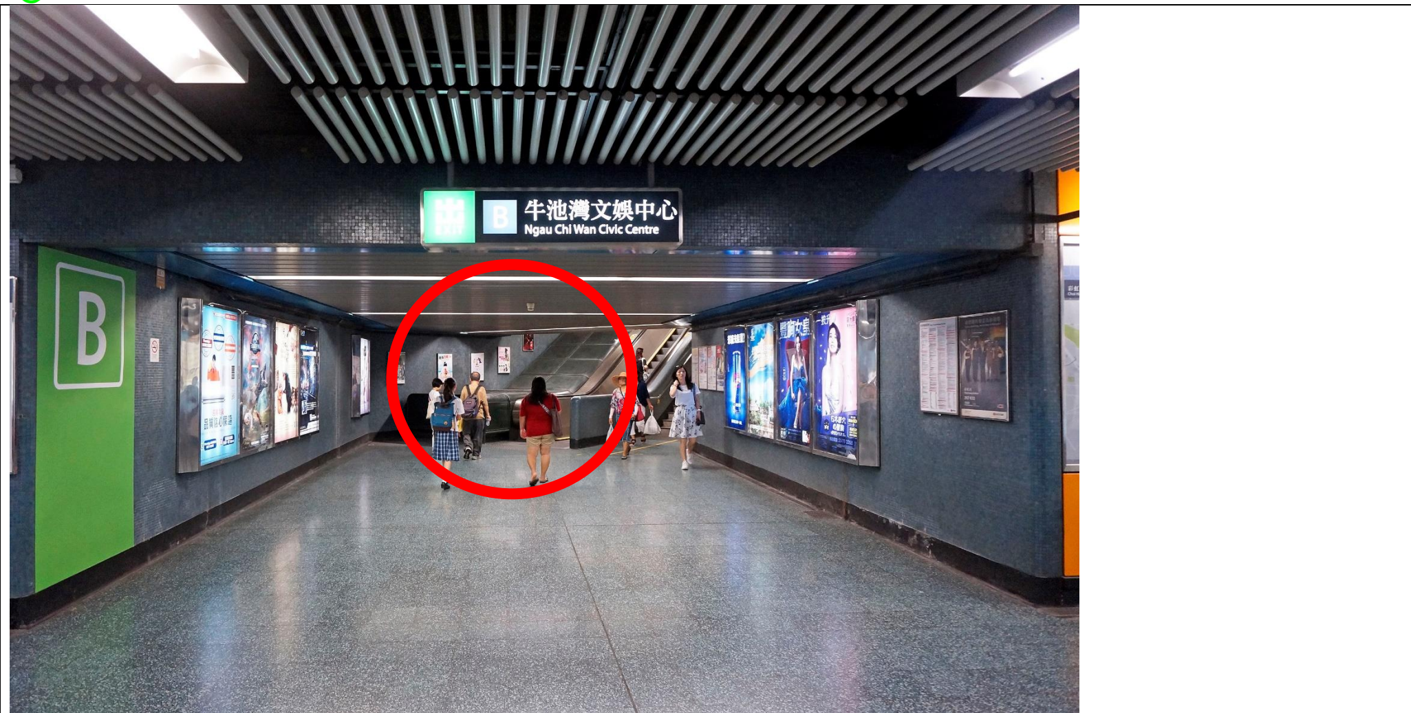
彩虹站 B 出口需在扶手電梯預留位(紅圈)加設放扶手電梯
