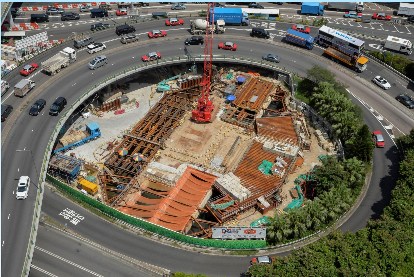
灣仔交匯處 - 暗渠改道工程
