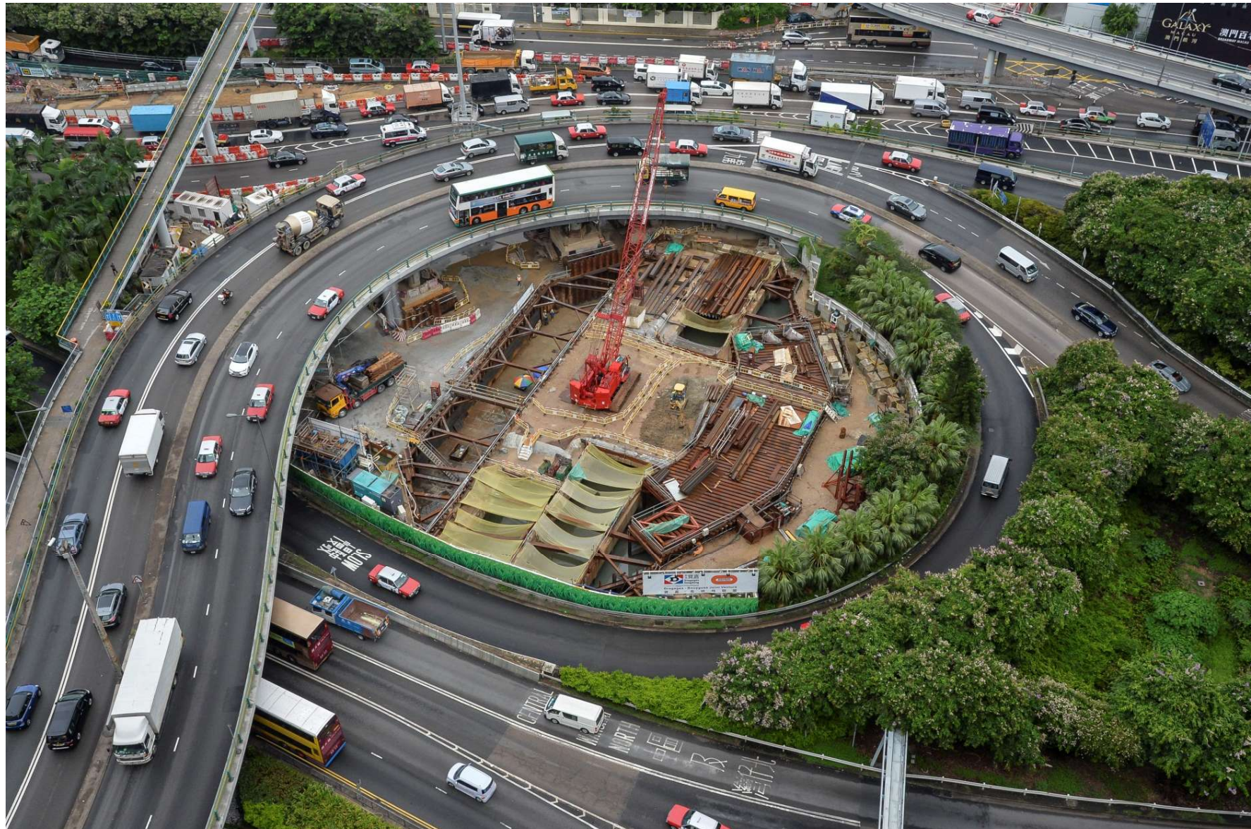
於隧道入口處休憩花園進行天橋地基及暗渠改建工程
