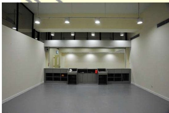
海軍商場郵政設施 重置工程進行中
