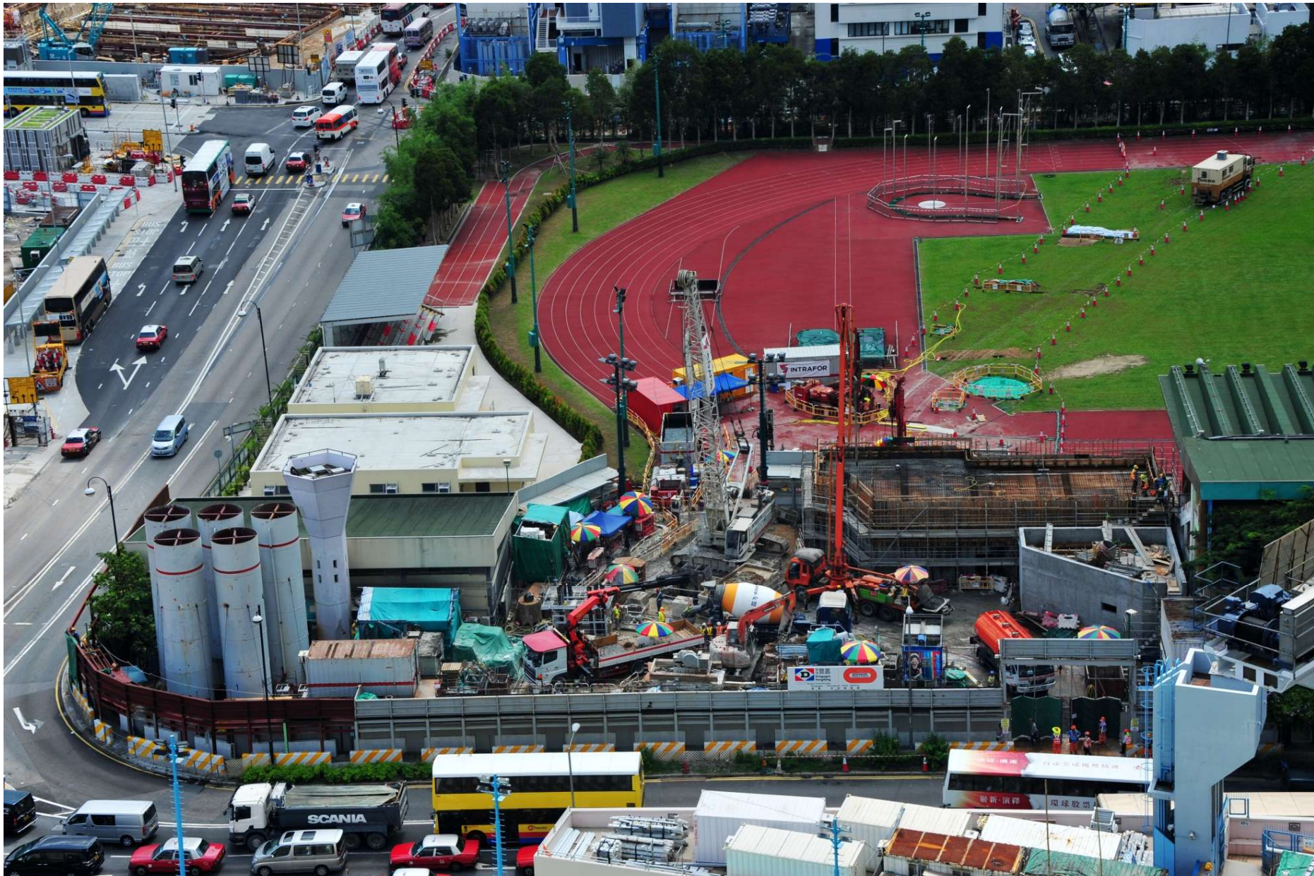
灣仔運動場北面位置進行地層加固工程
