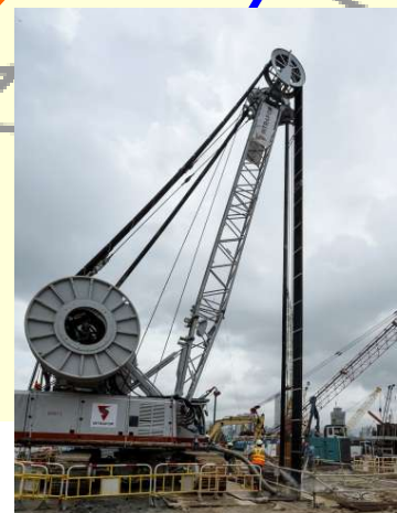
隧道鑽挖啟動豎井 垂直隔牆建造中
