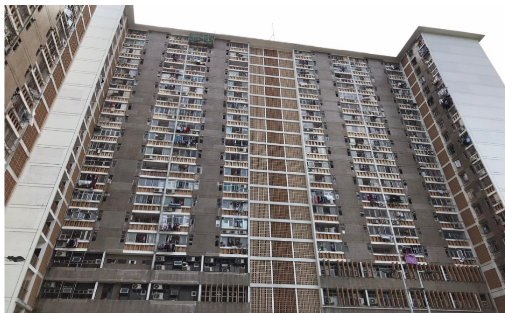
新田圍邨完工照片
