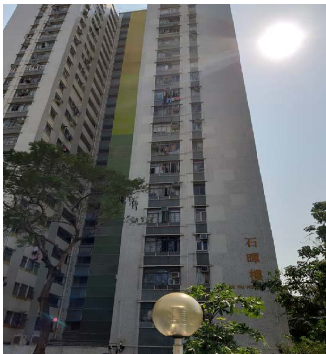
秦石邨完工照片
