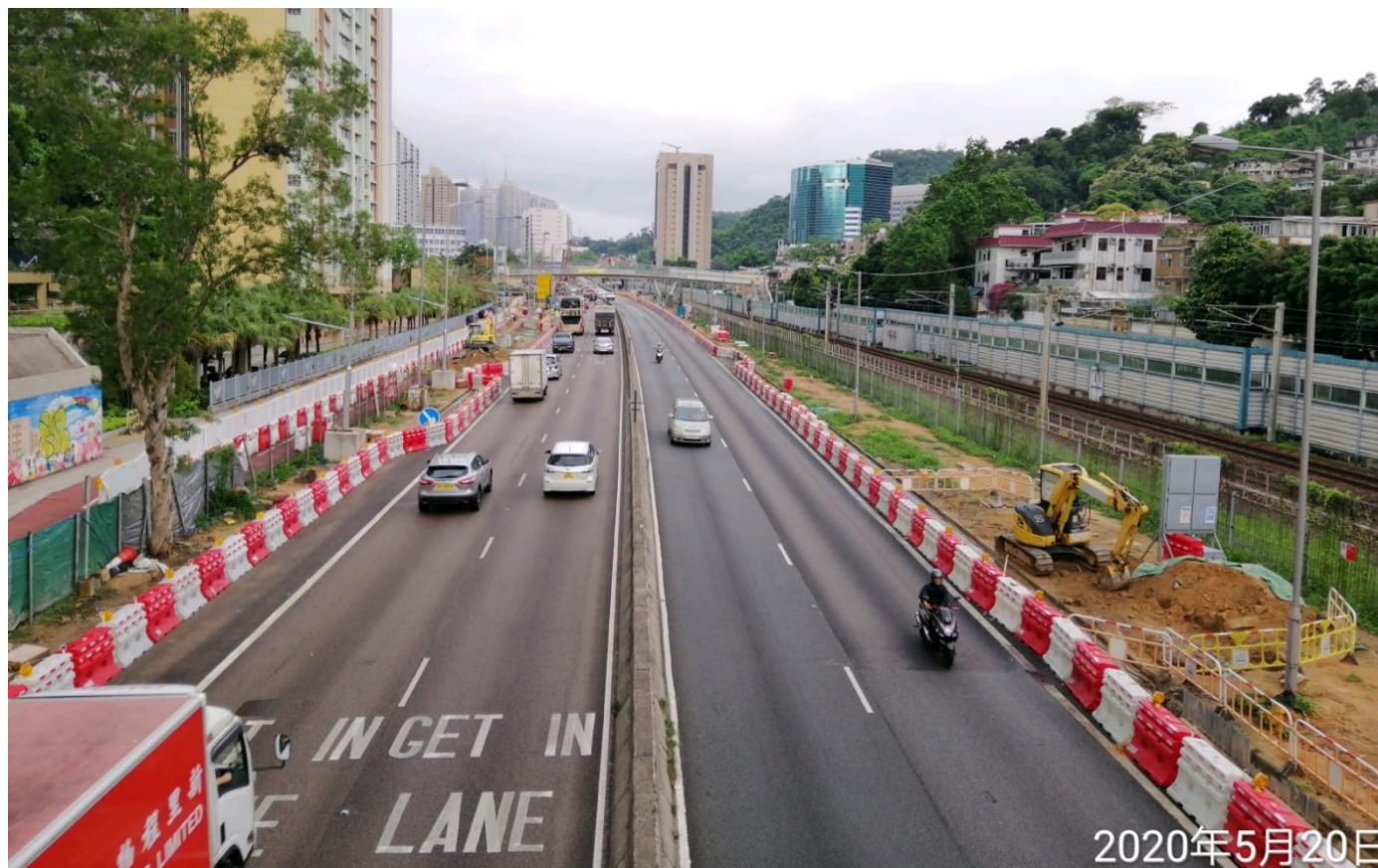
施工中的大埔公路(沙田段)擴闊工程
