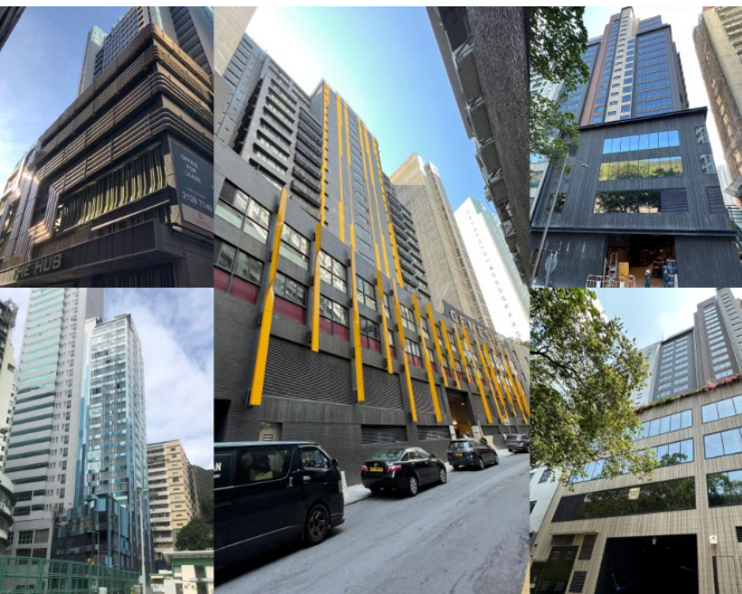
黃竹坑商貿區內進行整幢改裝作商業 / 酒店用途項目
