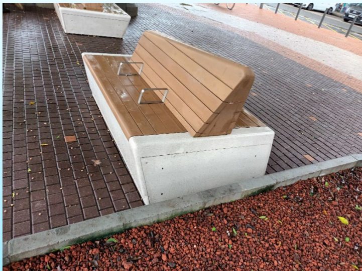
雙面座椅(階段 1) (仿真木及玻璃纖維石屎板加鐵架支撐)
