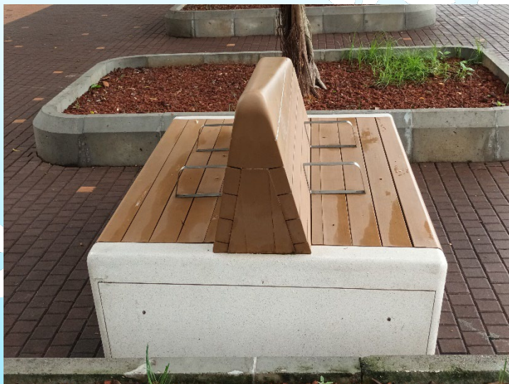
雙面座椅(階段 1) (仿真木及玻璃纖維石屎板加鐵架支撐)
