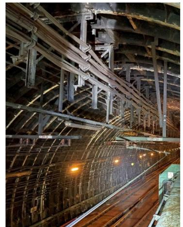
七月二十八日將進行的工序主要更換油麻地站附近一個約七米高的交叉渡綫隧道頂部的五十多個金屬吊架，這些吊架由通車至今已使用超過四十年，按其資產狀態及周期需進行更換。
