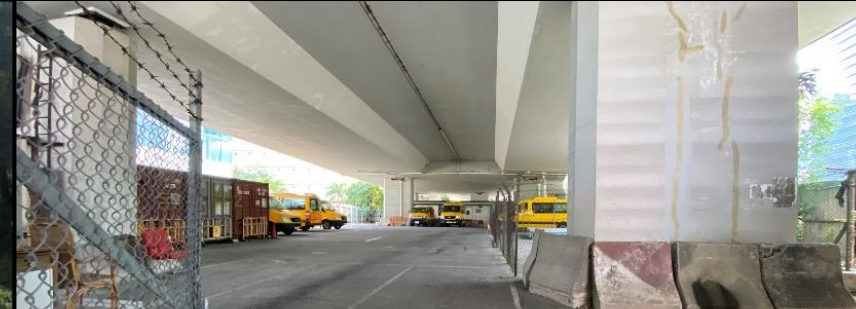
地段 Lot 3 – 天橋下路政署的維修廠 HyD's Maintenance Depot beneath flyover
