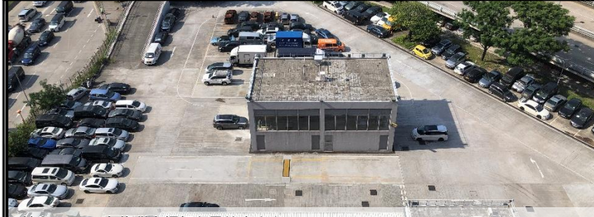
地段 Lot 1 – 九龍灣車輛扣留及檢車中心 Police Vehicle Examination and Detention Centre
