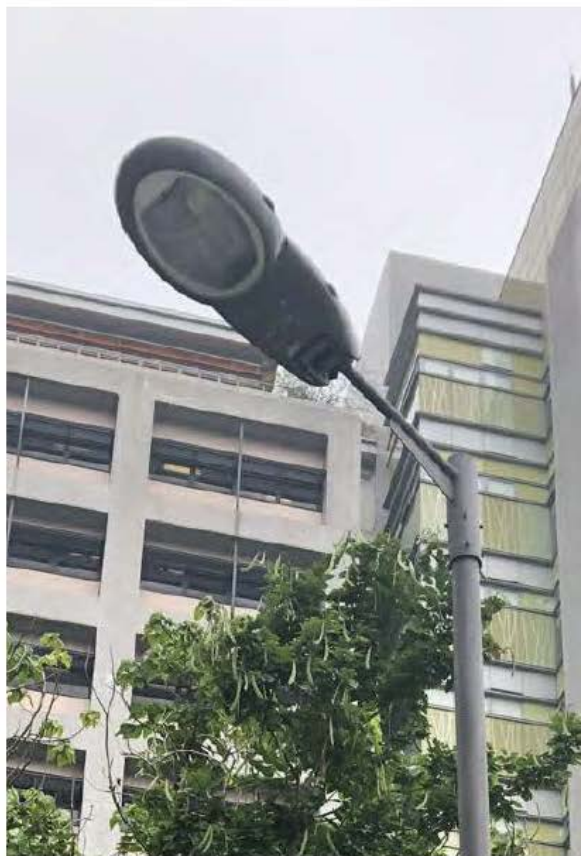
現場路政署燈柱
