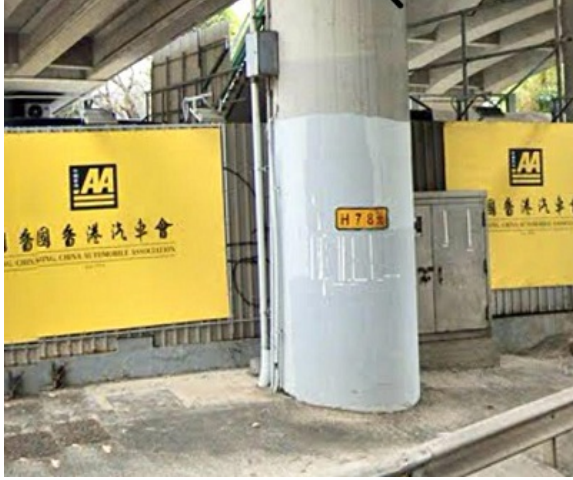
灣仔海底隧道天橋橋底
