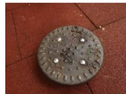
10玫瑰里兒童遊樂場_扭腰機的腳踏出現生鏽老化
