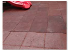
13萊佛里兒童遊樂場_兒童遊樂場地膠凹凸不平
