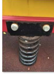
14第三街遊樂場_兒童搖搖彈弓椅設備的彈弓出現嚴重生銹情況
