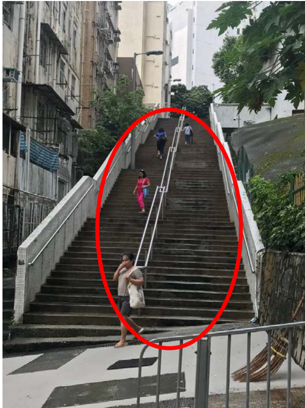
附件一 居民現長期使用長長樓梯出入屋苑
