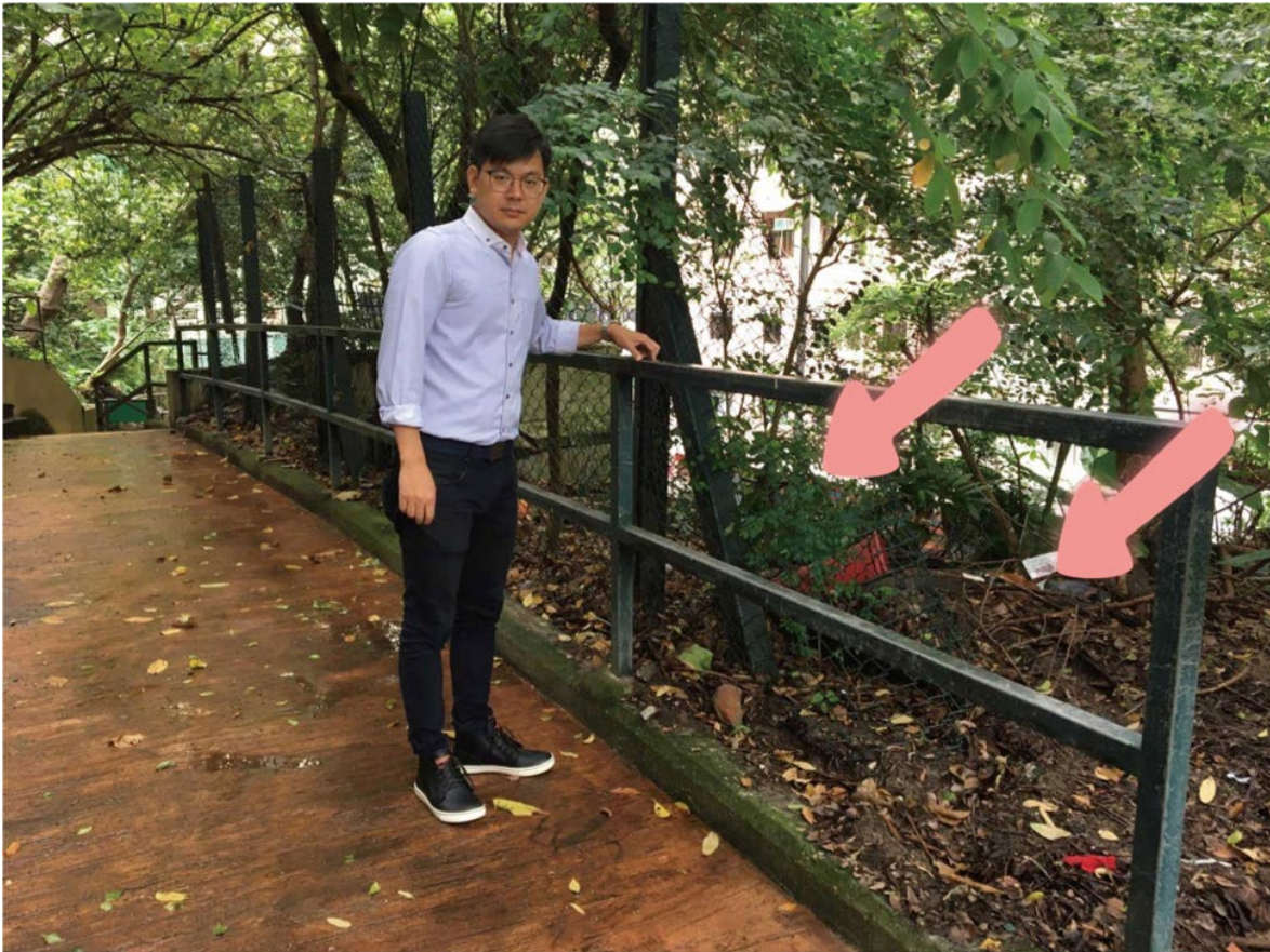
科士街堅尼地城遊樂場旁的樓梯斜坡
