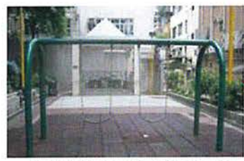
拆除現有兒童遊樂設施， 增設兩個鞦韆
