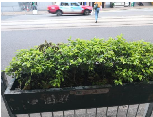
西營盤西區警署對處行人路花槽
