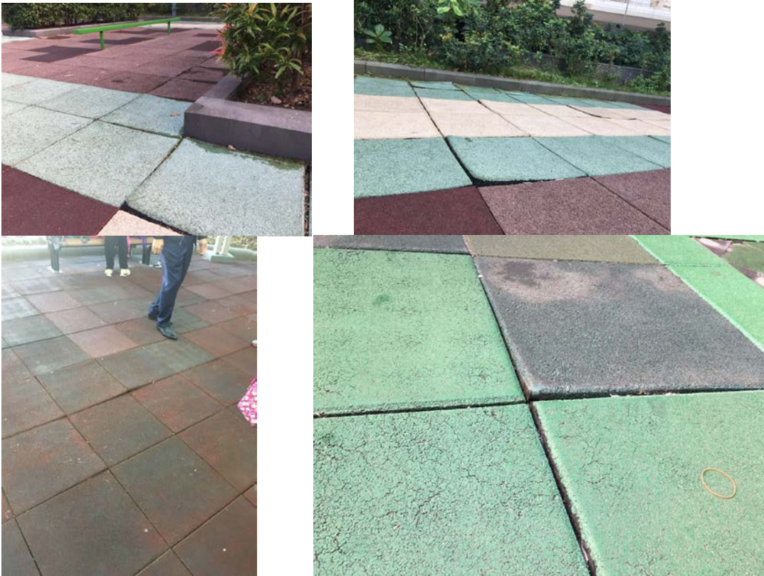
1. 中山紀念公園東面室外健身區、卑路乍灣公園兒童遊樂場、科士街兒童遊樂場地膠殘舊，凹凸不平。
